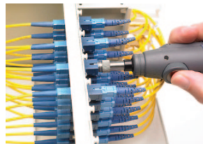
Ilustración 3-2. Inspección de paneles de conexiones
